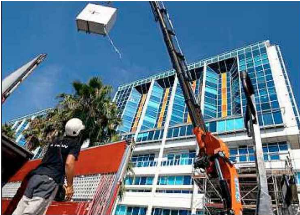
Livraison spectaculaire, hier matin, à la Fondation Lenval qui a ouvert sa façade amovible pour laisser entrer un IRM dernière génération venu d'Allemagne.
